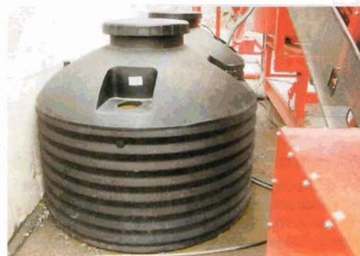
Recycling pur: Hier werden nicht nur RC-Zuschläge aus aufbereiteten Betonbauteilen für die neue Betonherstellung verwendet, sondern auch Regenwasser, das in zwei Tanks vorgehalten wird.
